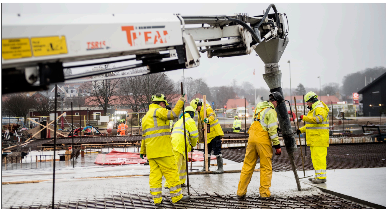
Terrændæk og fundamenter er nu færdigstøbte og klar til montage af betonelementerne. Foto: Tim Kildeborg Jensen
